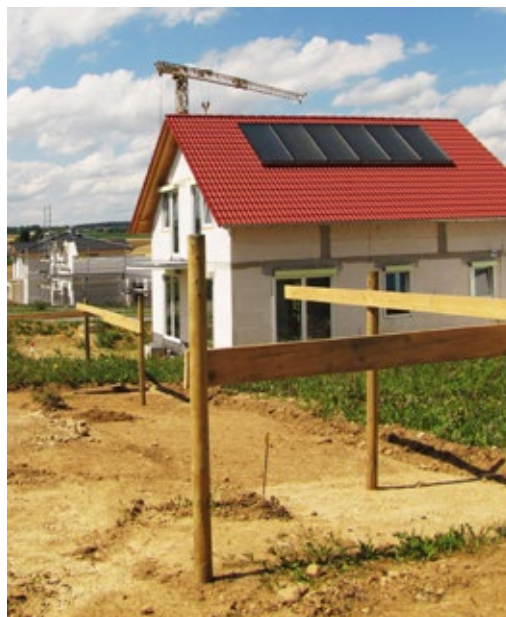
Einheimischenmodelle dienen der Deckung des Wohnbedarfs der ortsansässigen Bevölkerung und damit dem sozialen Zusammenhörigkeitsgefühl und der Bewahrung ortsspezifischer Kultur, Tradition und Bräuche
