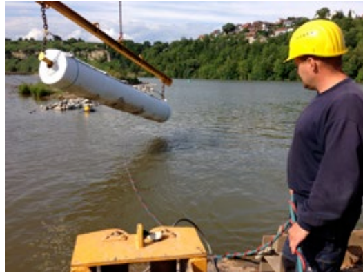
Die Arbeiten an den Uferzonen des Neckars bei Ludwigsburg schreiten zügig voran
